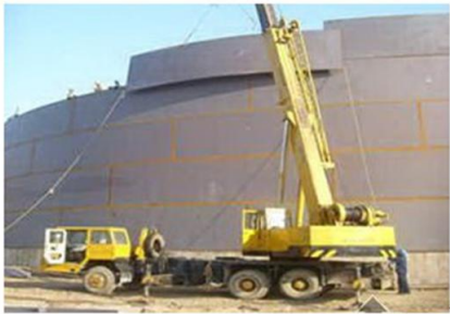
图 5.10 大型储罐吊车就位壁板
