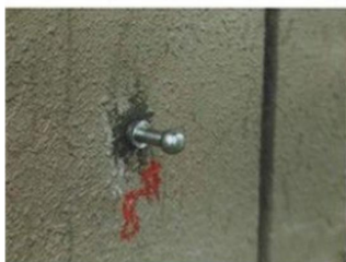
图13-3-2 沉降观测点保护
